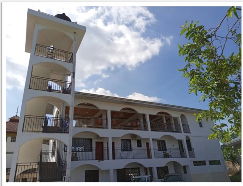
Figure 5 - La façade avec les escaliers vue du parking
