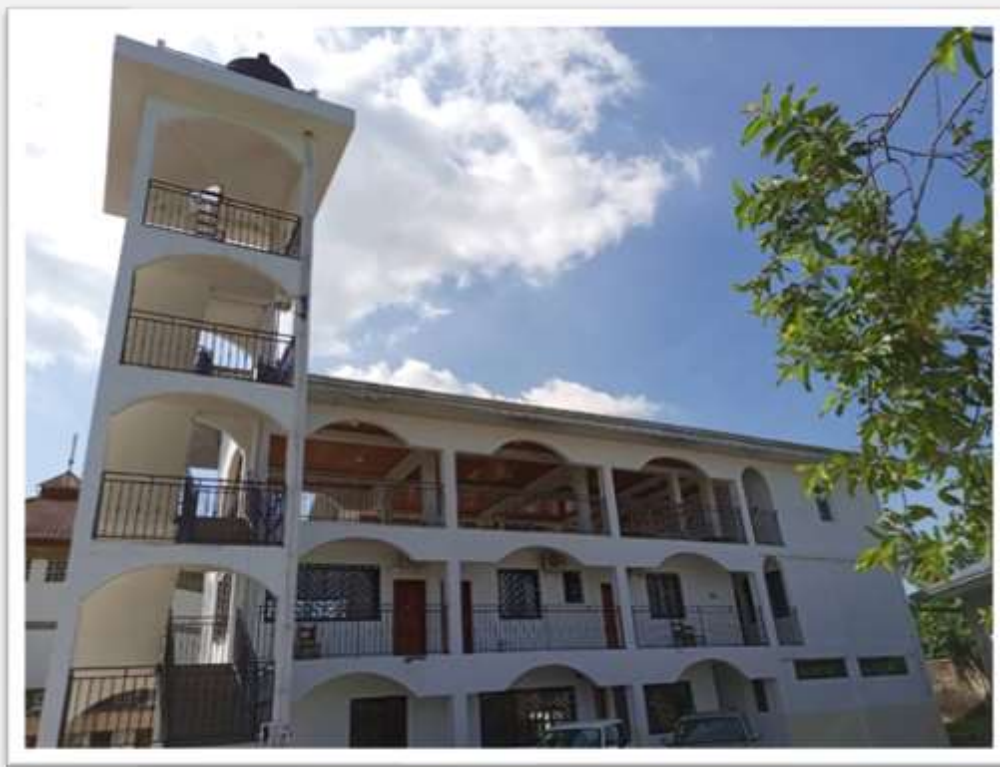
Figura 5 – La facciata con le scale viste dal parcheggio
